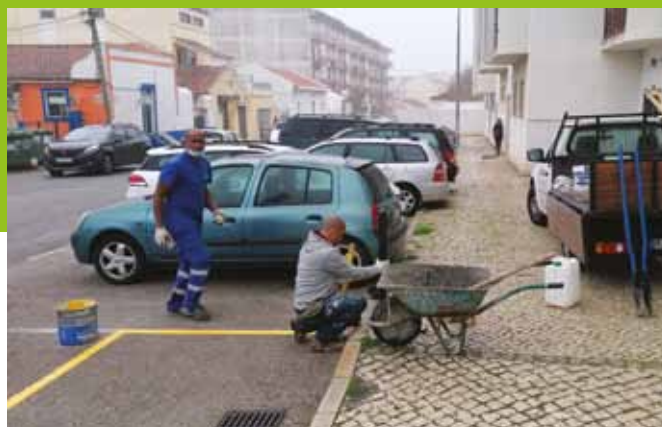
Pintura de sinalização
